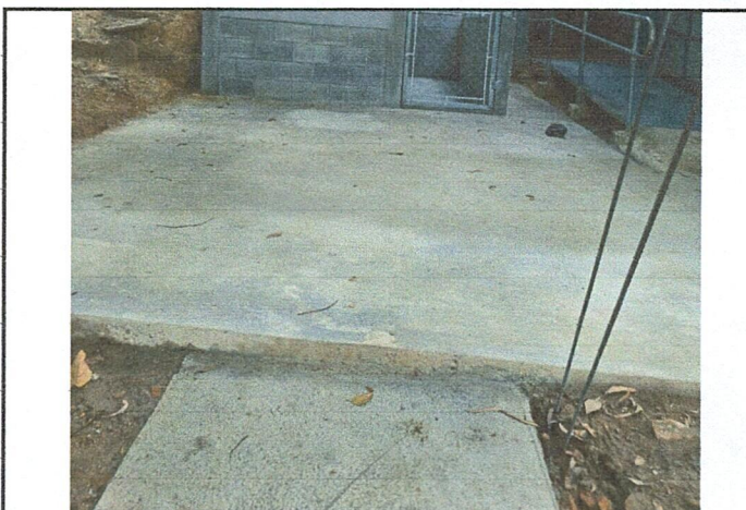
Foto 4: Colocación de torta de concreto de 7 cm de espesor, con un área total de 40 m2
