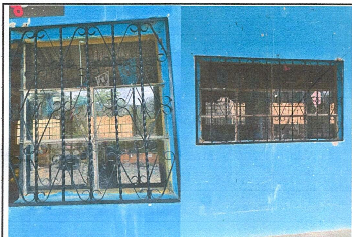
Foto 3: Suministro e instalación de balcones metálicos para la seguridad del módulo de aula, en diferentes dimensiones
